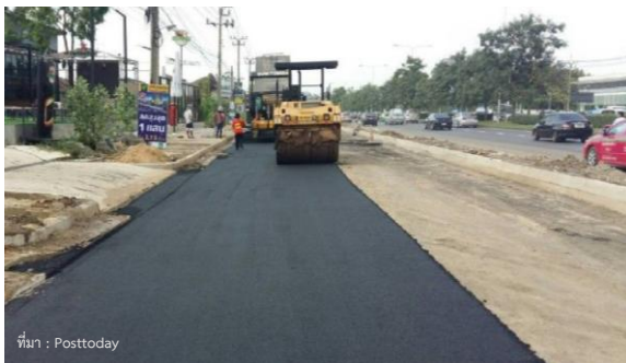
การก่อสร้างเพิ่มช่องจราจร การขยายถนน
