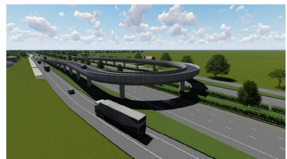
ก่อสร้างสะพานกลับรถเกือกม้า
